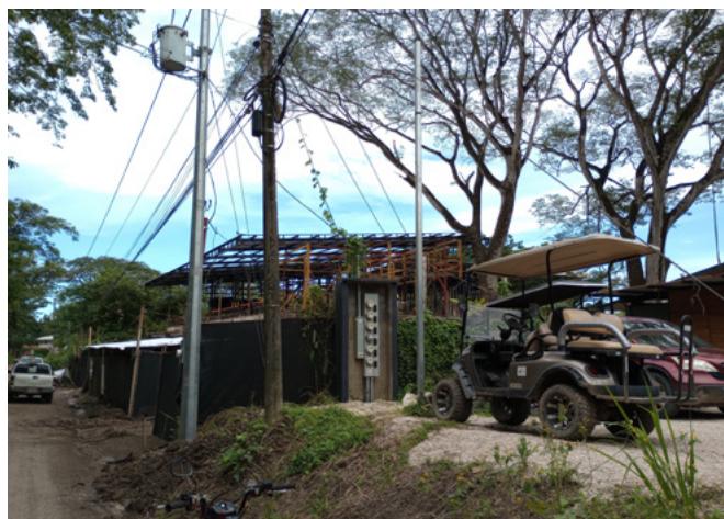
Foto 14: Construcción en desarrollo de una casa de lujo en Playa Pelada, Guanacaste
