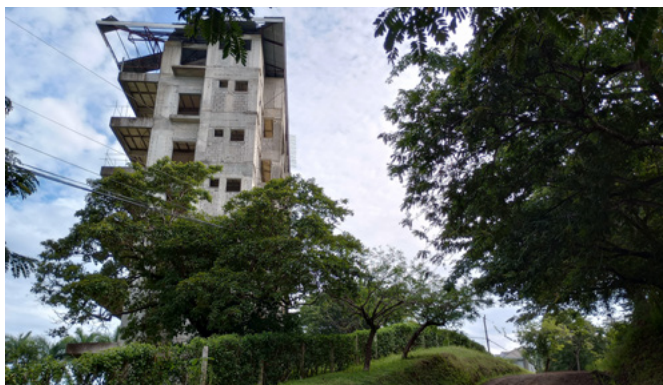
Fotos 8 y 9: Construcción en curso cerca de Playa Manzanillo, Puntarenas / Proyecto inmobiliario abandonado en Playa Azul, Guanacaste.
